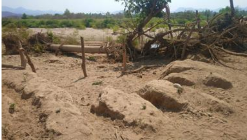
Foto 3. Colindancia con Río Ixtapa, donde se observa la erosión por el crecimiento del Río Ixtapa
